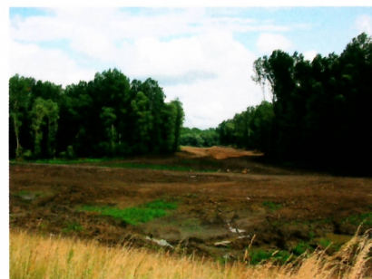
Készül a bevezető csatorna
